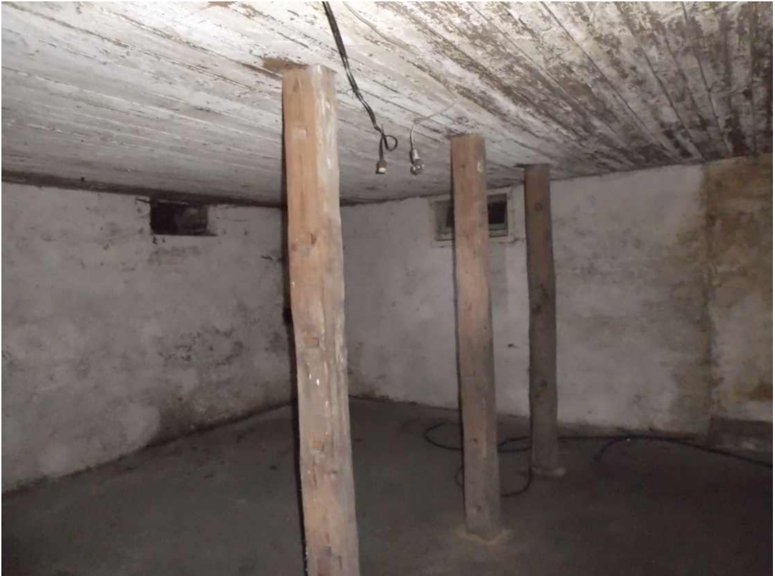
Fot. 17. Mocno zawilgocona ściana i deskowanie w piwnicy
