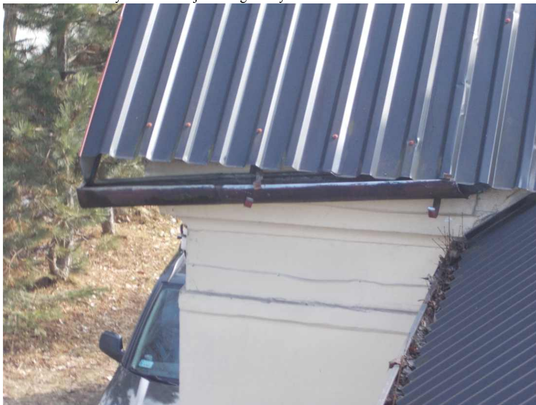
Fot. 13. Zapchana rynna, uszkodzona obróbka blacharska
