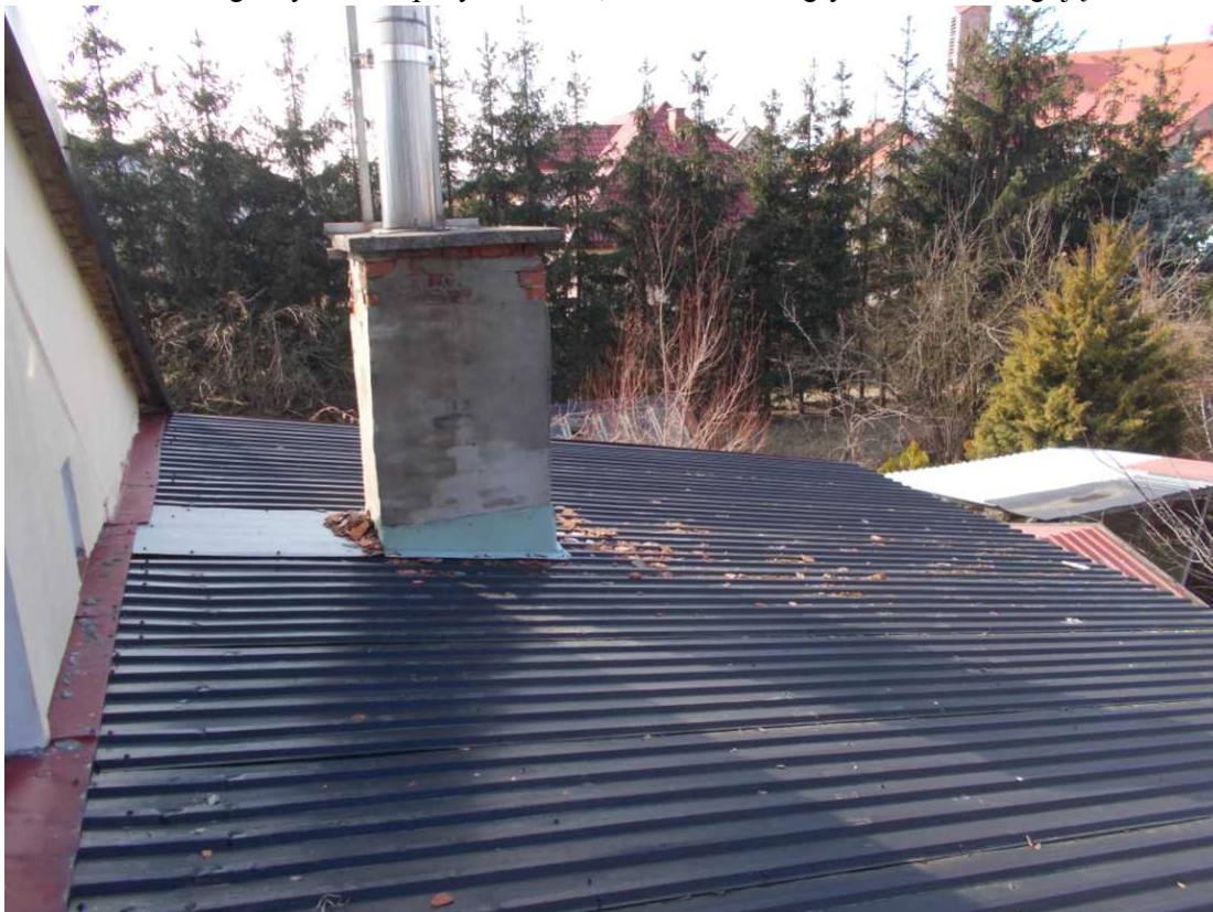
Fot. 9. Widok ogólny dachu przybudówki, skruszone cegły komina zalegają na dachu
