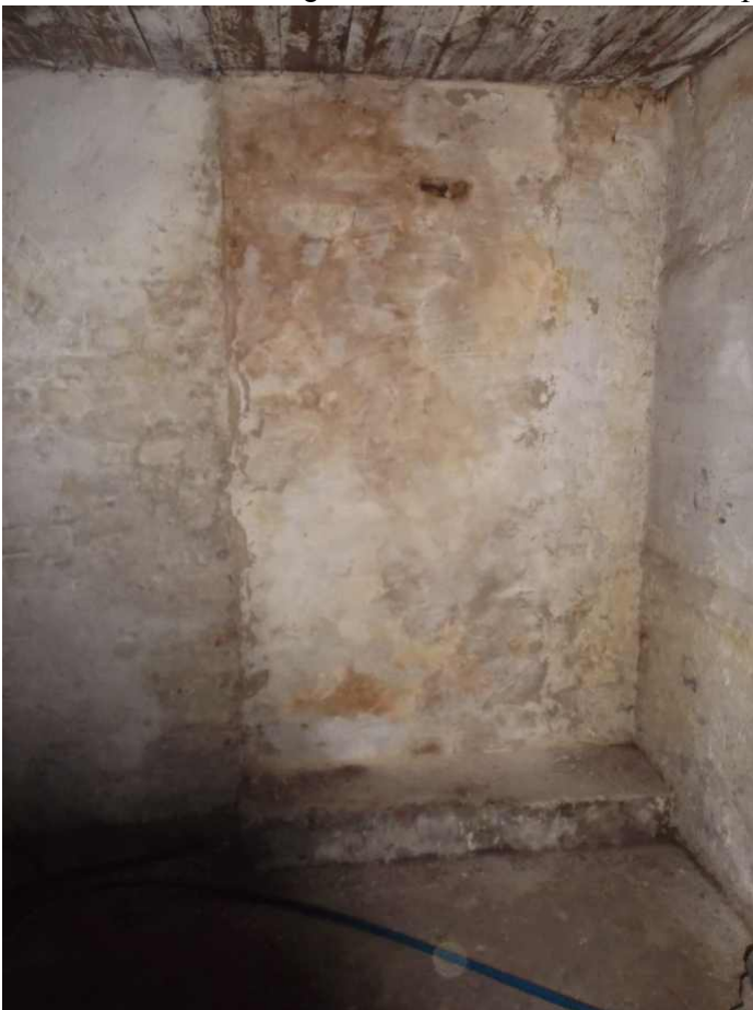
Fot. 17. Mocno zawilgocona ściana i deskowanie w piwnicy
