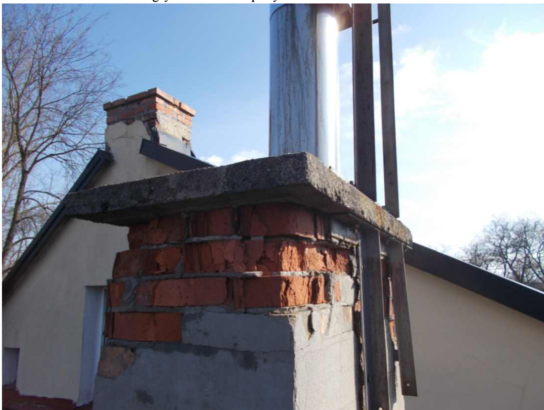
Fot. 11. Uszkodzone cegły na kominie przybudówki
