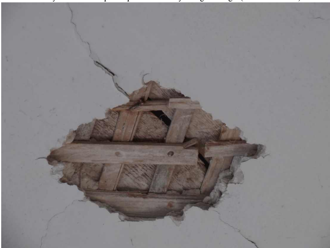
Fot. 39. Odkrywka 4 – strop nad parterem budynku głównego (widok od dołu)
