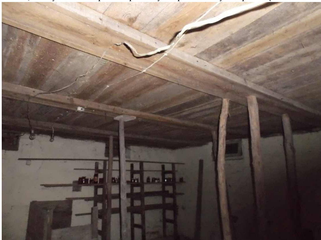
Fot. 15, 16. Tymczasowo podstemplowany strop drewniany nad piwnicą
