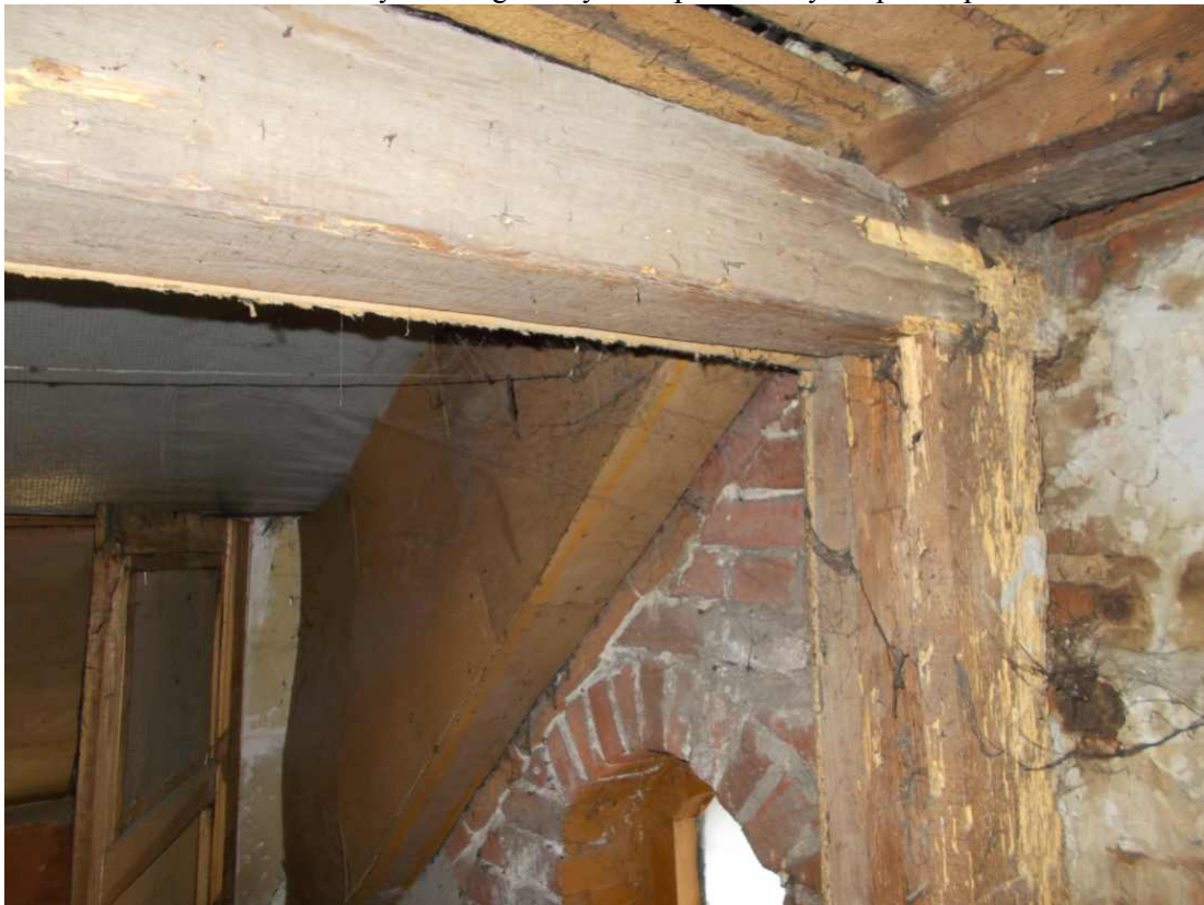
Fot. 24. Poddasze nad budynkiem głównym – spróchniały słupek i płatew
