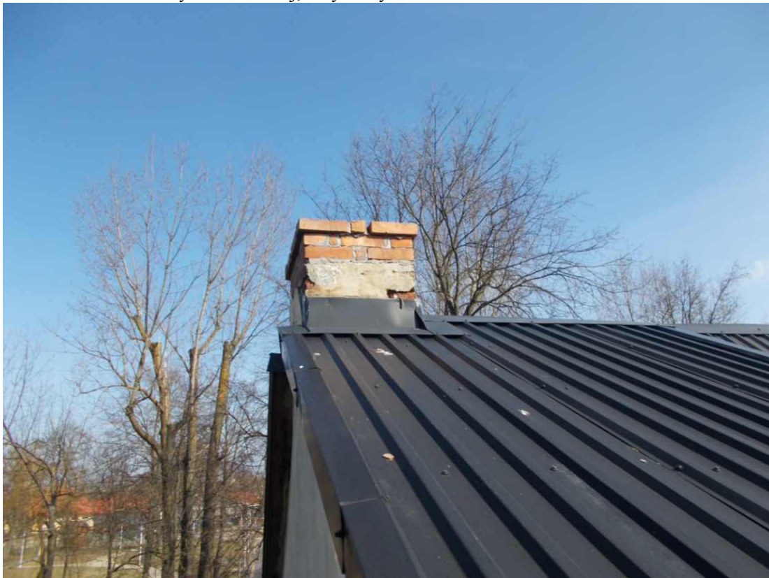
Fot. 10. Brak nasady kominowej, ubytki tynku na kominie
