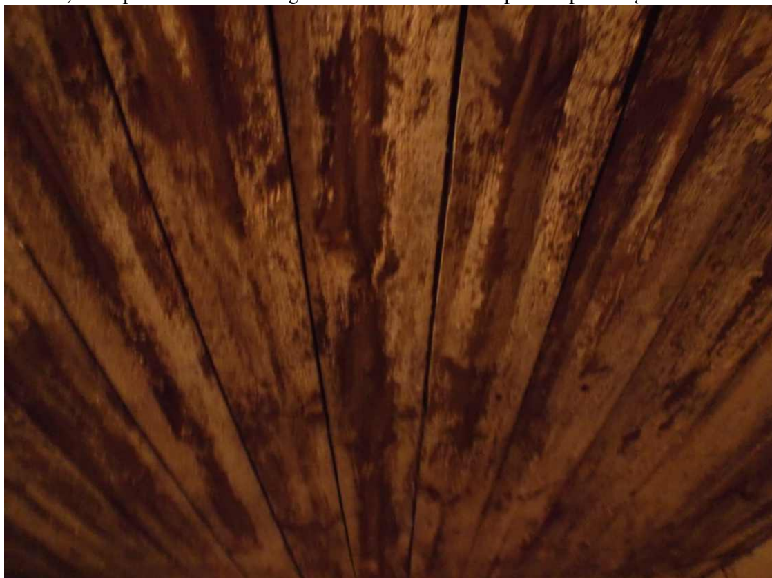
Fot. 18, 19. Spróchniałe i zawilgocone deskowanie stropu nad piwnicą
