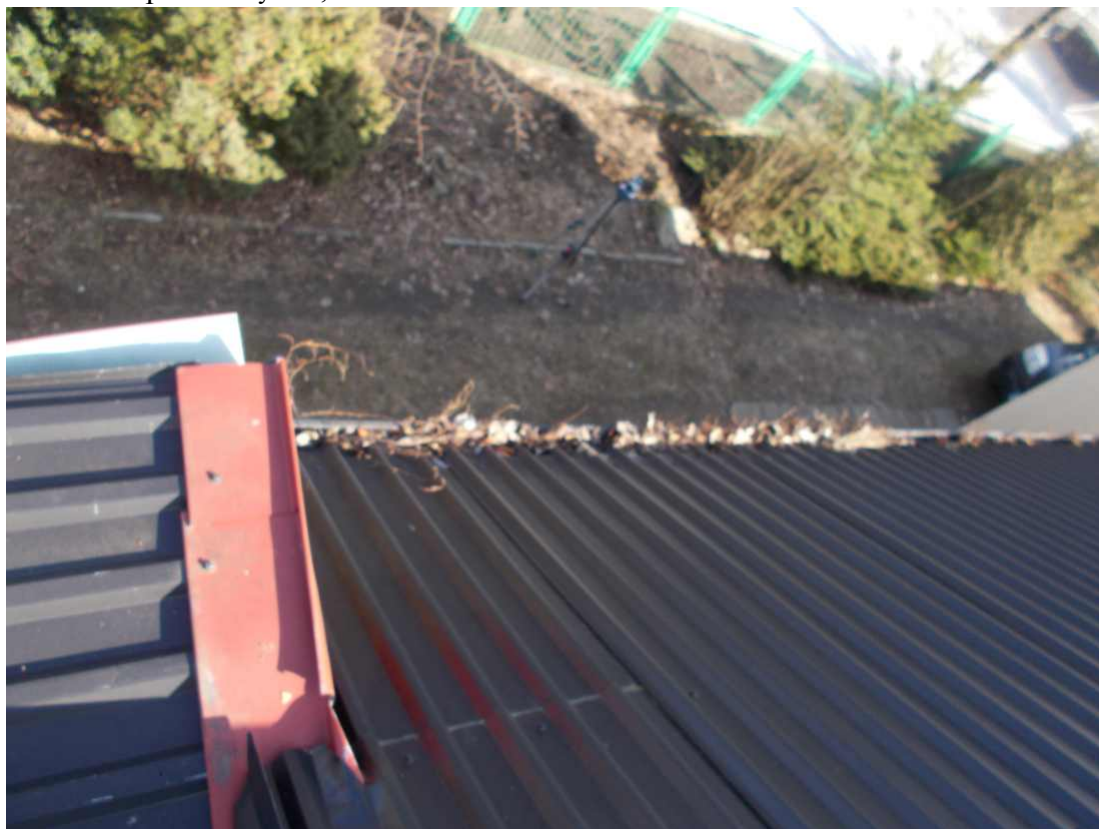
Fot. 13. Zapchana rynna, uszkodzona obróbka blacharska
