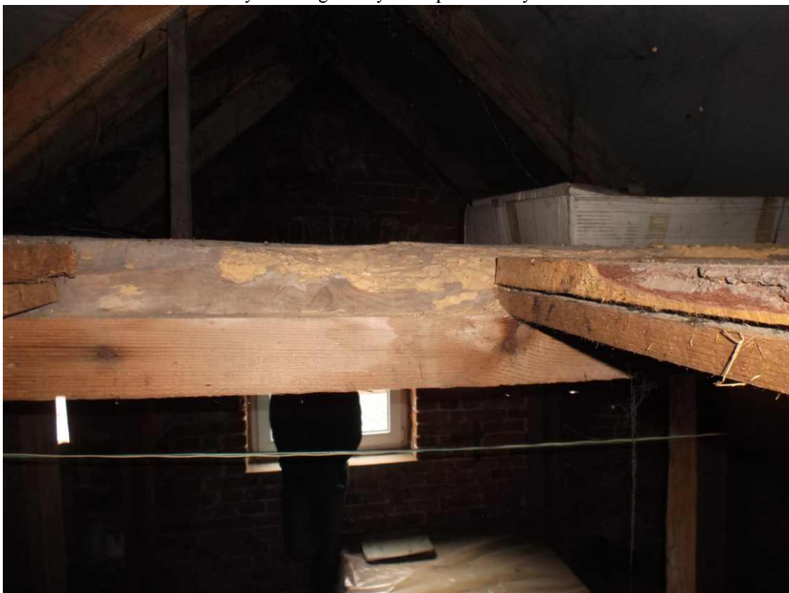
Fot. 25. Poddasze nad budynkiem głównym – spróchniały kleszcz
