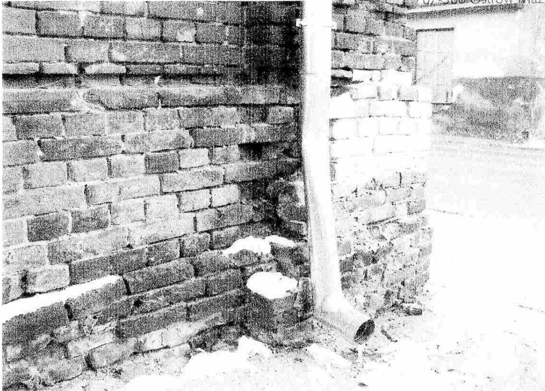
FOT.7. Widok uszkodzonego odwodnienia połaci dachowej oraz niestarannego wykonania naprawy uszkodzonego narożnika budynku. Widoczne zagrybienie ściany przyziemia –do naprawy
