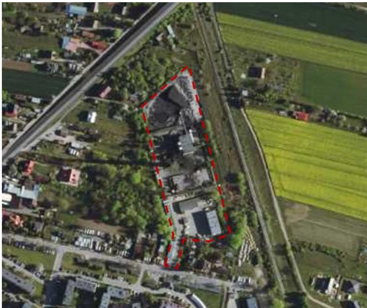
Rysunek 3.4.5 Widok z powietrza lokalizacji kotłowni węglowej
