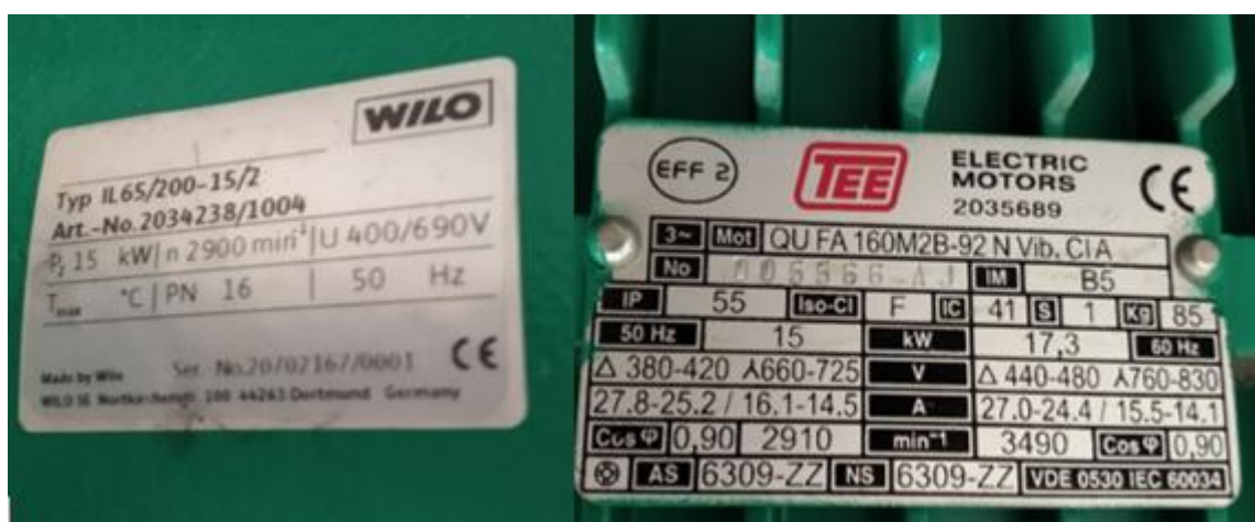
Rysunek 3.1.9 Zdjęcia tabliczek znamionowych pompy (z lewej) i silnika (z prawej) zestawu pompowego
