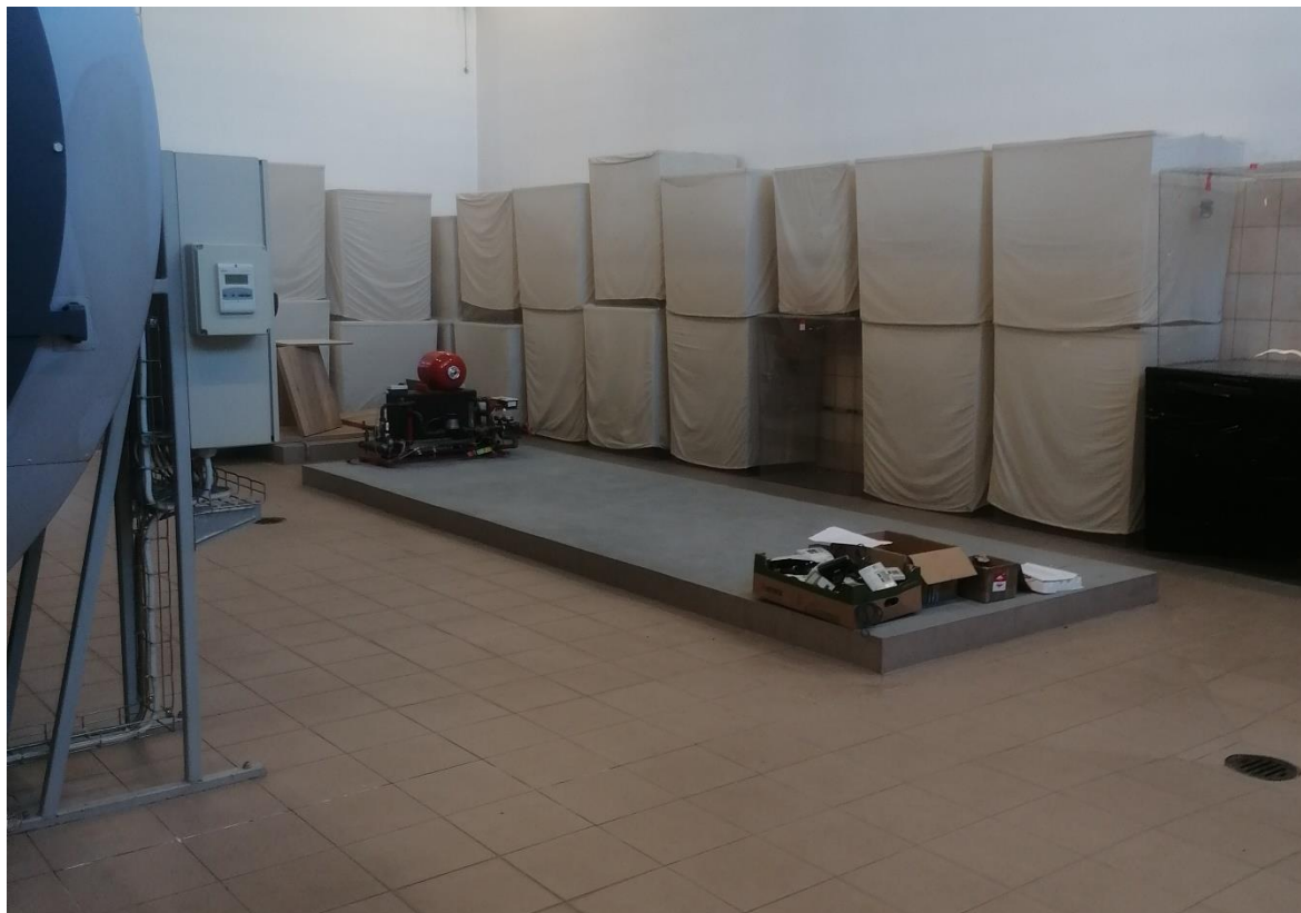
Rysunek 3.4.2 Przygotowany fundament pod zabudowę kolejnego kotła gazowego
