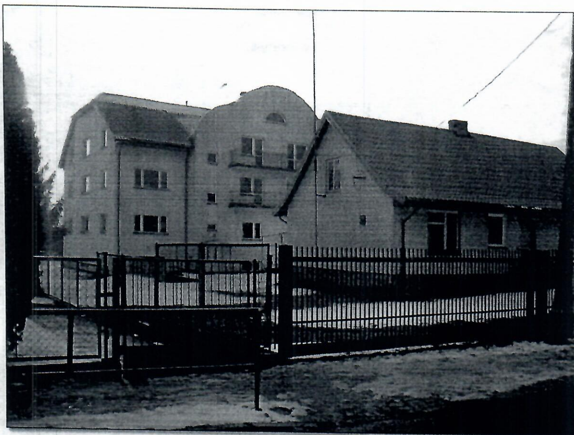
Wyceniany budynek usługowo mieszkalny
